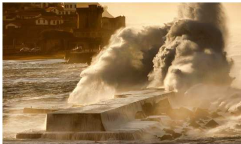
Déplacement des blocs
