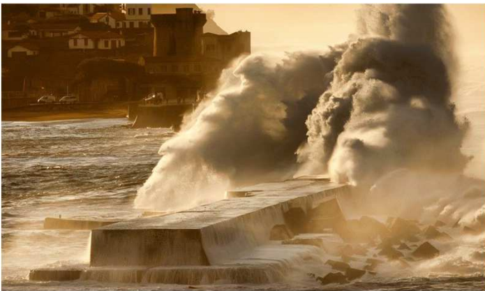
Déplacement des blocs
