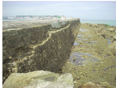
Endommagement local maçonnerie
